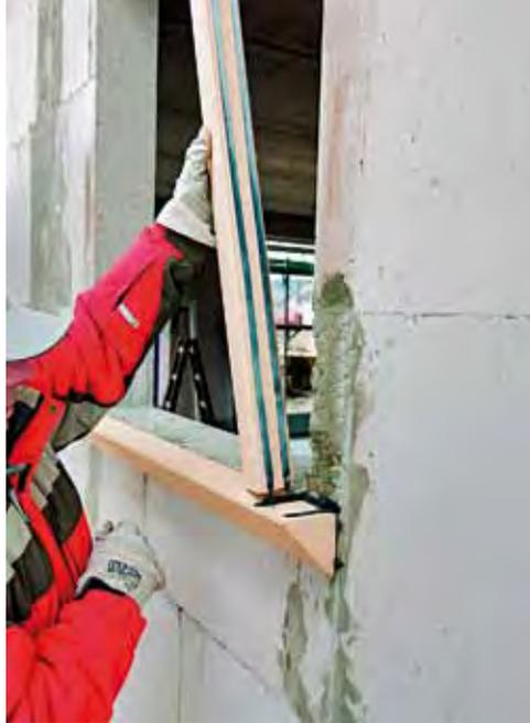
Die Zargenelemente werden nach der Vorbehandlung der Klebeflächen mit einem Primer verklebt und mit einer Distanzschraube gesichert
