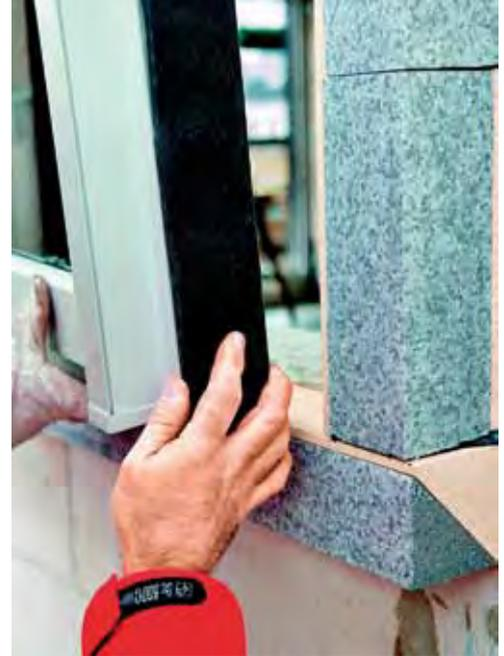
Der Dämmkeil wird auf die Schrägfläche der Zarge geklebt. Die gute Anbindung an das Folgeraster erhöht die Wärmedämmung
