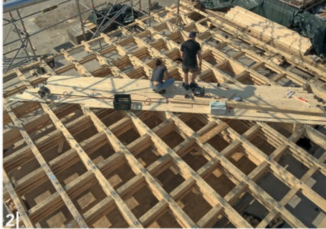
1| Ein Trägerrost aus Altholz bildet die reversible, dauerhafte Dachkonstruktion.
