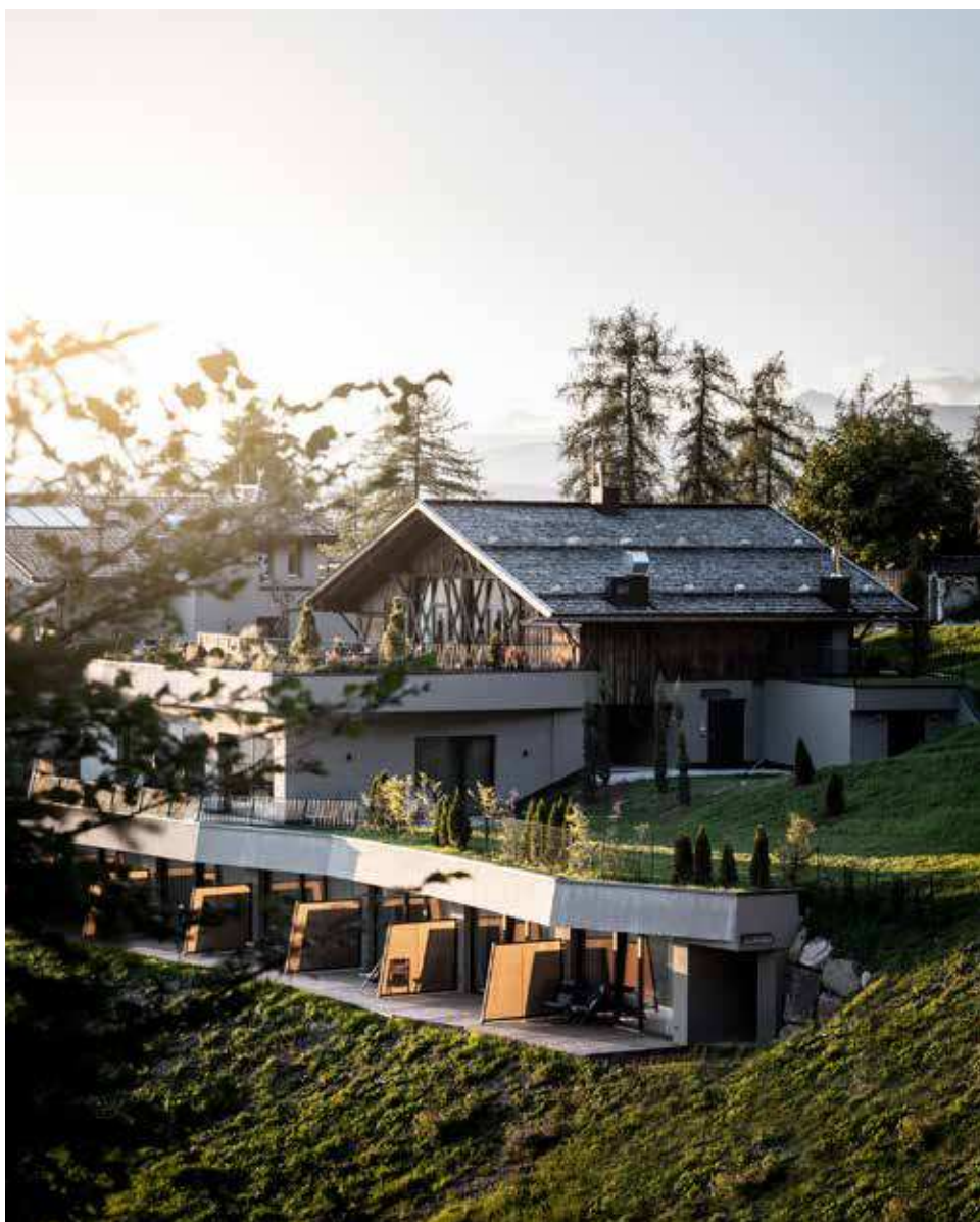
Das traditionelle Restaurant in den Tiro- ler Alpen wurde um 17 Gästezimmer er- weitert, die unter dem Bestandsgebäu- de in den Hang gebaut sind
