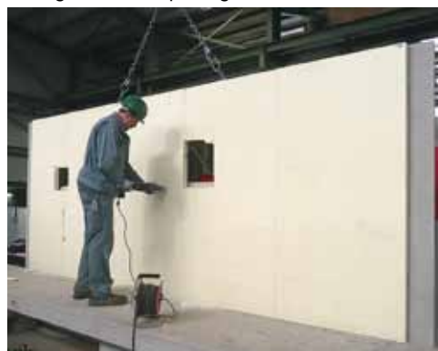
Freilegen der Aussparungen
