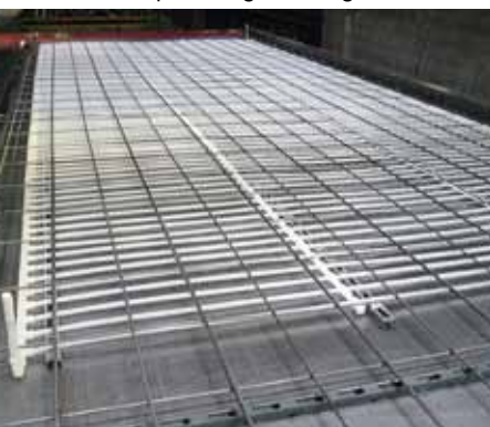
Flächentemperierung im Fertigteillement
