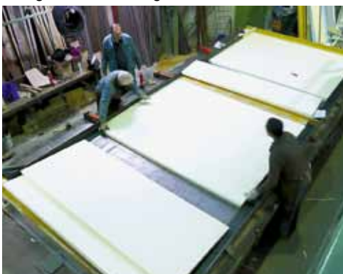
Einlegen der Dämmung im Werk
