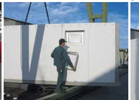
Einsetzen des Fensterabdeckrahmens als Dämmung
