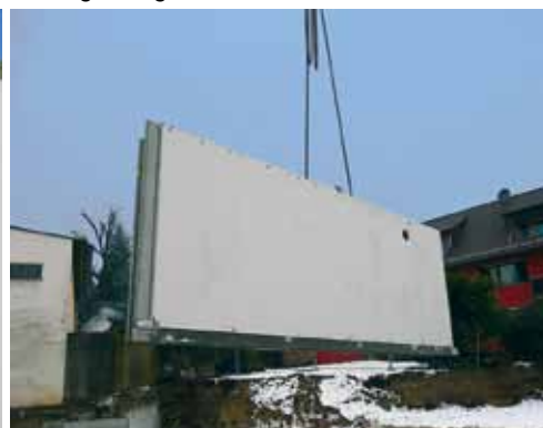
Montage der gedämmten Außenwände
