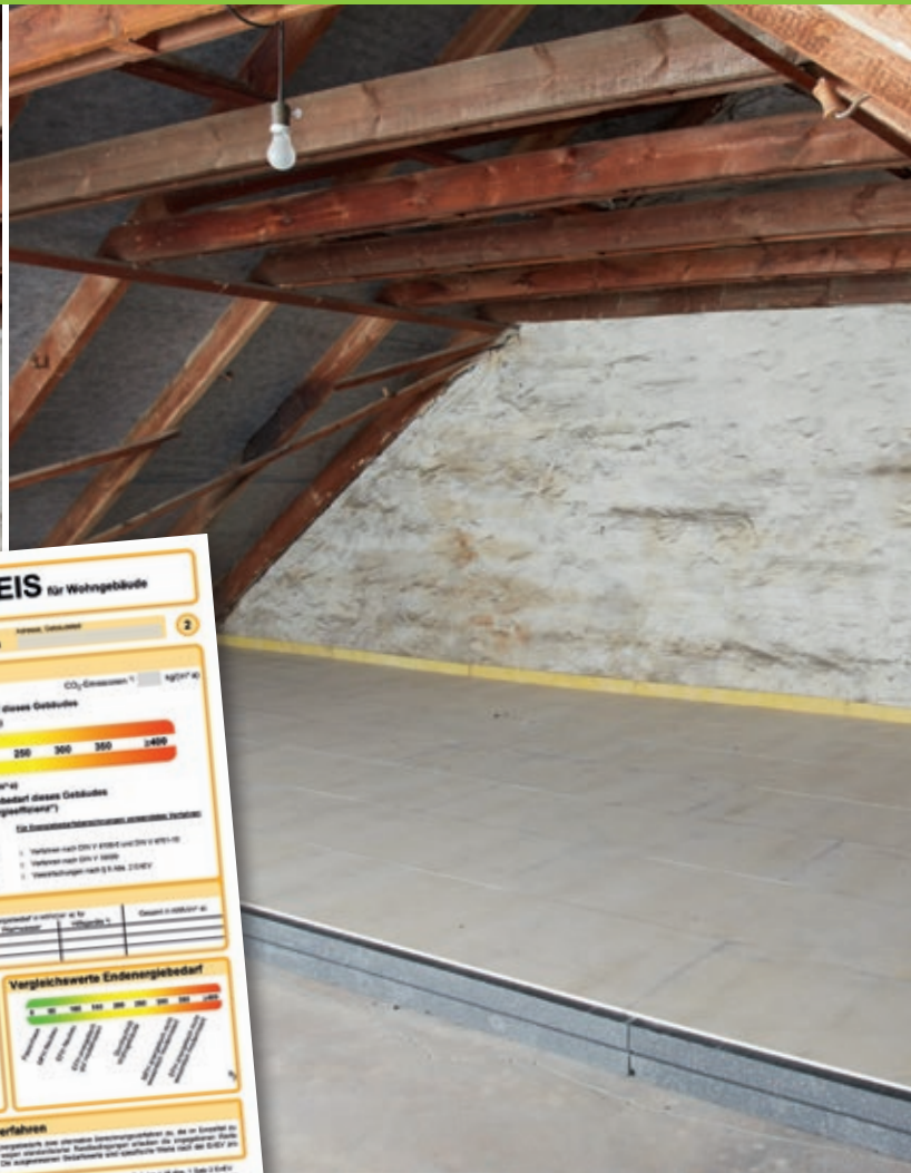
Sanierter Dachboden in Bearbeitung
