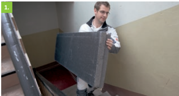
1. Das Rigidur Dachbodenelement eignet sich aufgrund seiner Abmessung (500 x 1.500 mm) optimal für den Transport durch enge Treppenhäuser und passt durch jede Dachbodenluke.
