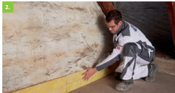
2. Um Wärmeverluste an den Randbereichen zu vermeiden, wird entlang der Wände ein Mineralwolle-Randdämmstreifen verlegt.
