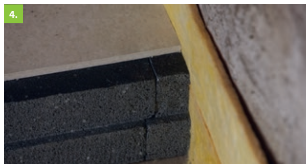
4. Alternativ kann auch der überstehende EPS-Streifen der letzten Anschnittplatte abgetrennt und an die Wand angelegt werden. Somit lassen sich ganze Elemente einlegen. Wichtig ist, dass eine vollflächige Auflage ohne einen Luftspalt entsteht.
