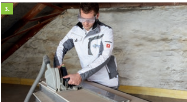
3. Bevor die Verlegung des ersten Elements in der linken hinteren Raumecke vorgenommen werden kann, wird der überstehende EPS- und Plattenfalz mit einer Säge bündig abgetrennt.
