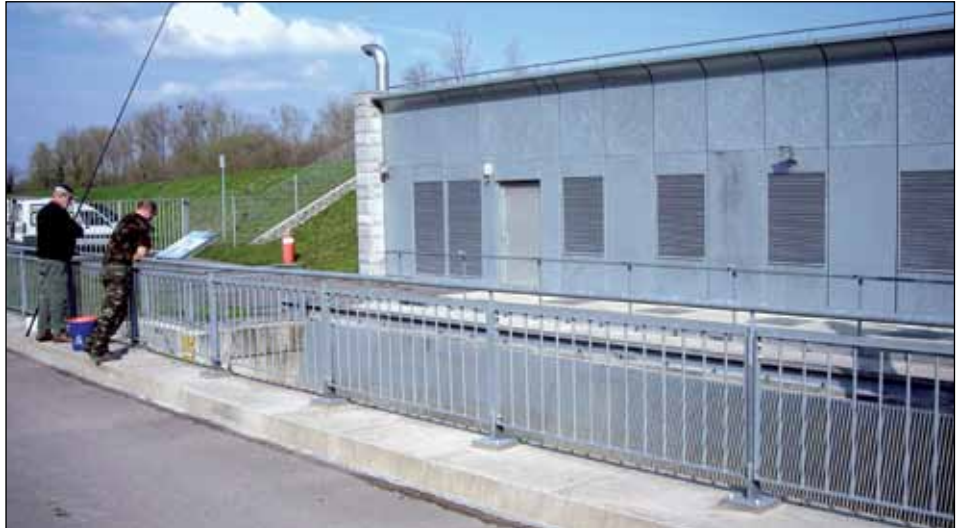
2 Fassade aus feuerverzinkten Blechen
