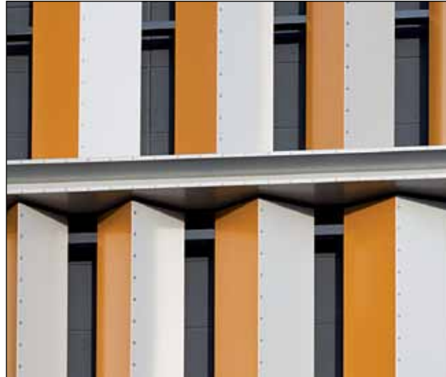
4 Aluminium-Fassade mit feuerverzinkter Tragkonstruktion
