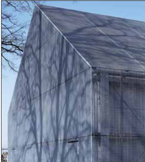
3 Feuerverzinkte Gitterrost-Fassade
